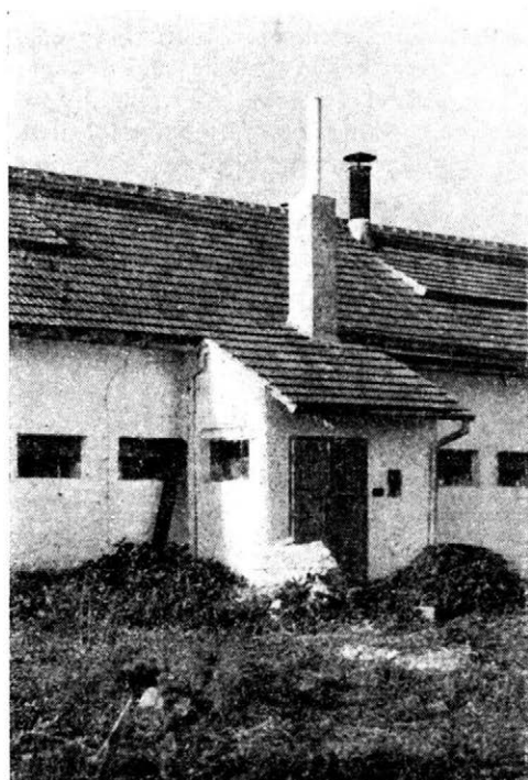
2. Adaptace shozu pro slámu u typové porodnice pro komín klimatizačního zařízení
